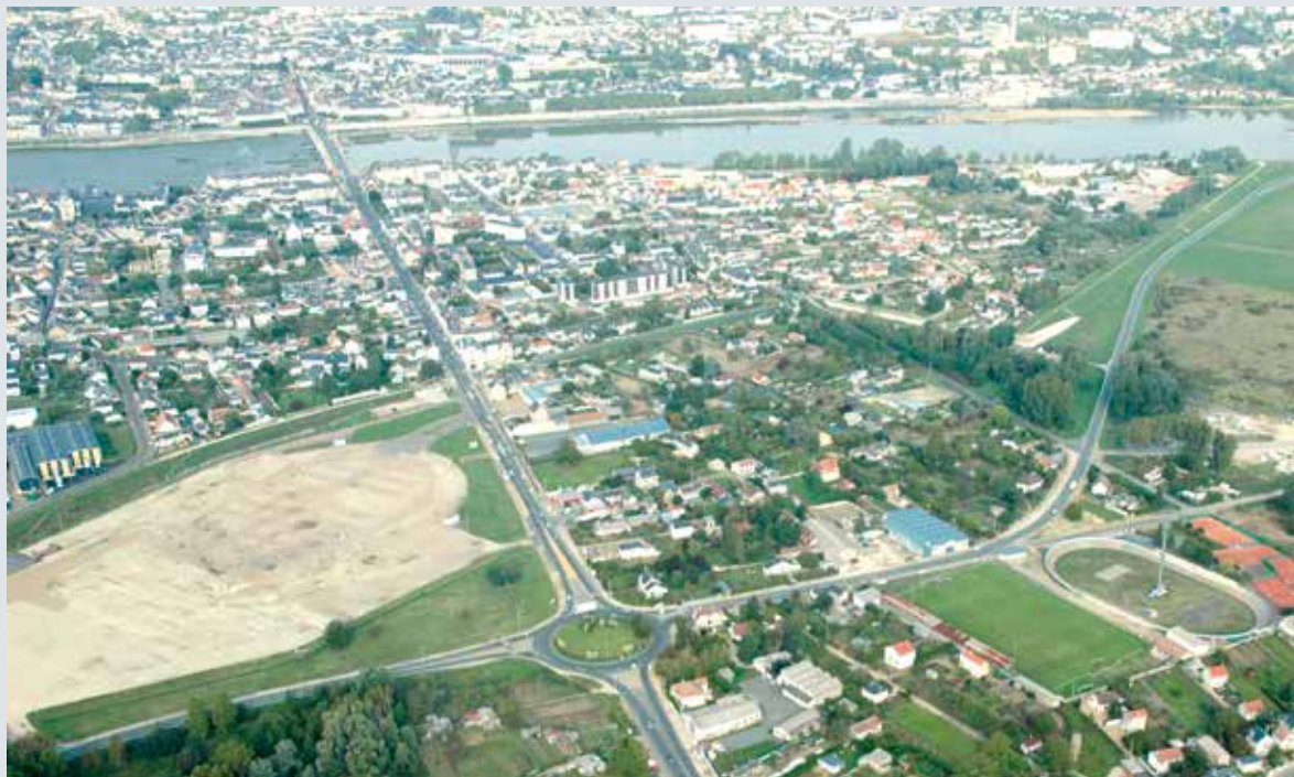
Le déversoir de la Bouillie avant (ci-dessous) et après (ci-contre) déconstruction. © Agglopolys
