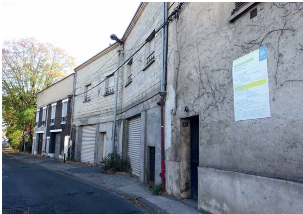
Bâtiment promis à la démolition chemin des Pêcheurs. © Agnès Fernandez
