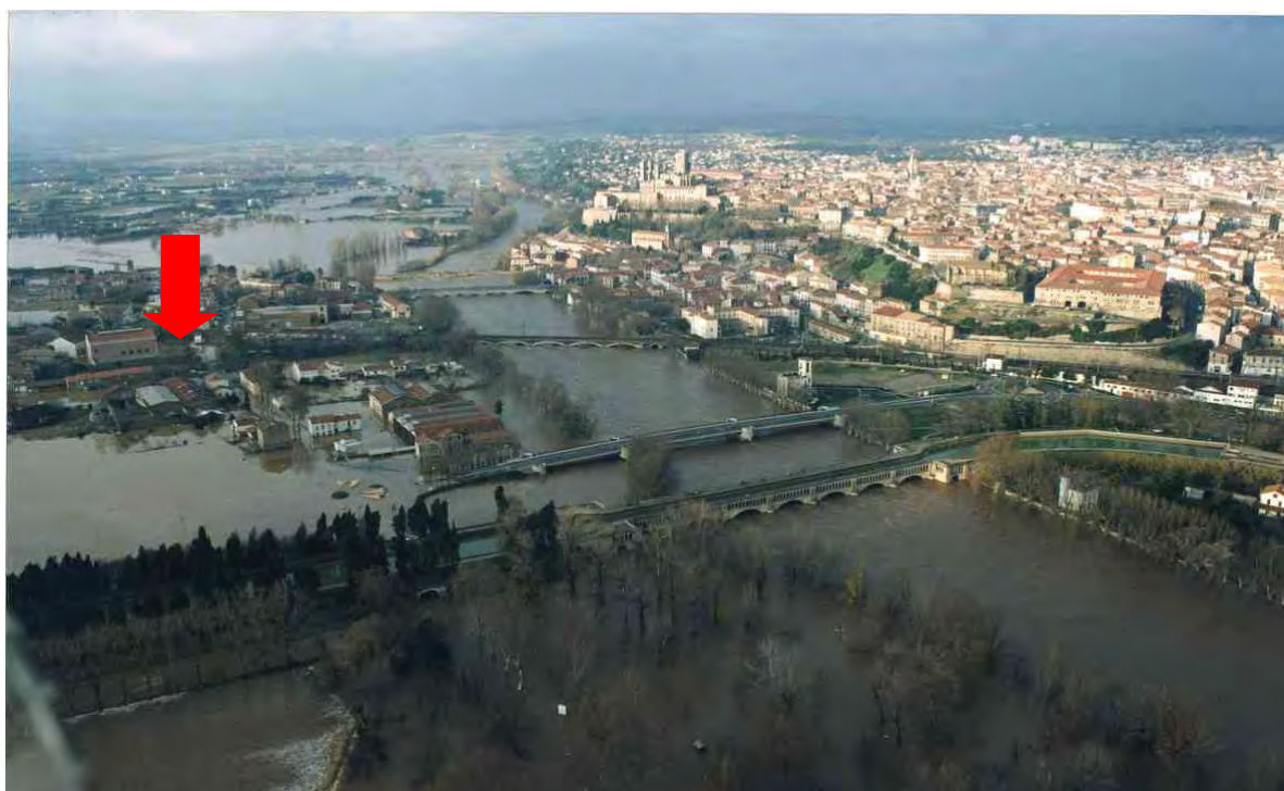
Vue aérienne du quartier du Faubourg lors de la crue de 1995 (au premier, le Pont Canal sur l'Orb – prise de vue en aval de Béziers)
