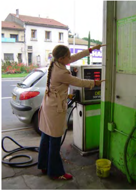
Pompes à essence vulnérables compte-tenu des hauteurs d'eau des crues historiques à savoir : 1996 - indication supérieure et 1987 - indication inférieure (garage route du Pont Vieux)
