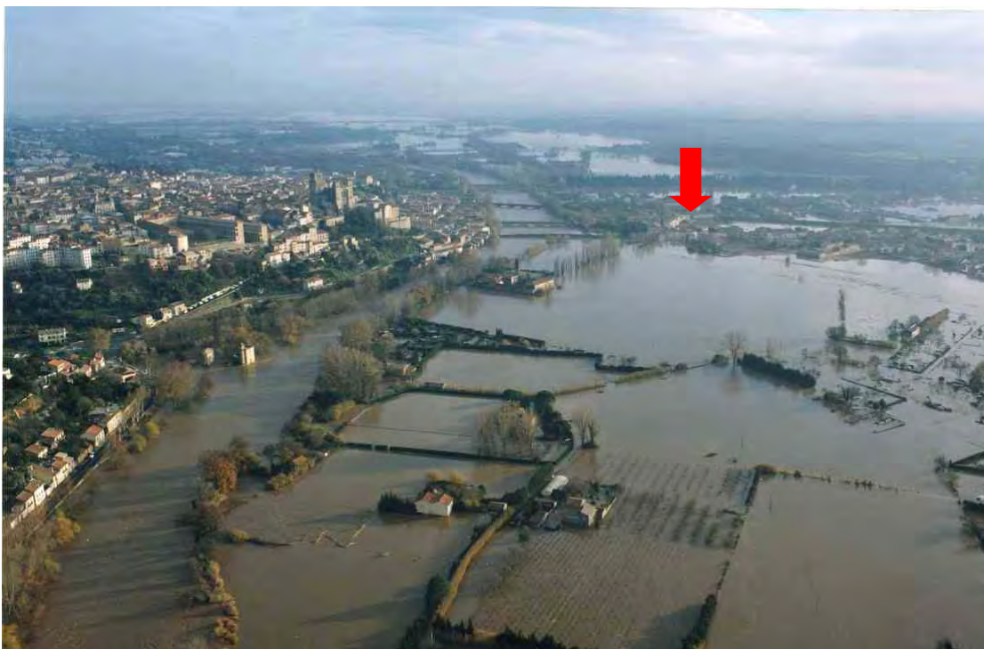
Vue aérienne du quartier du Faubourg lors de la crue de 1995 (prise de vue en amont de Béziers)
