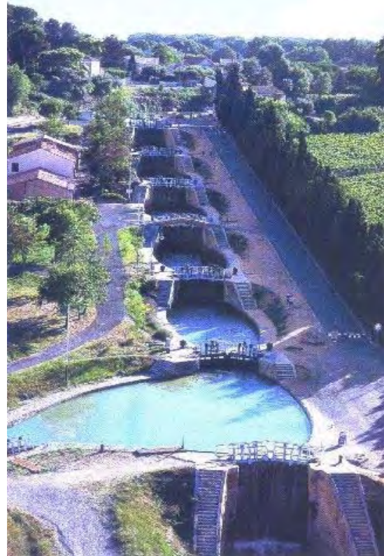
Vues aériennes des écluses de Fonsérannes (à noter la forme ovoïde originale des écluses)
