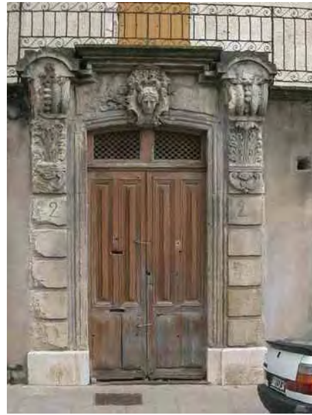
Détail d'un portail d'entrée en face de la résidence Emile Aïn
