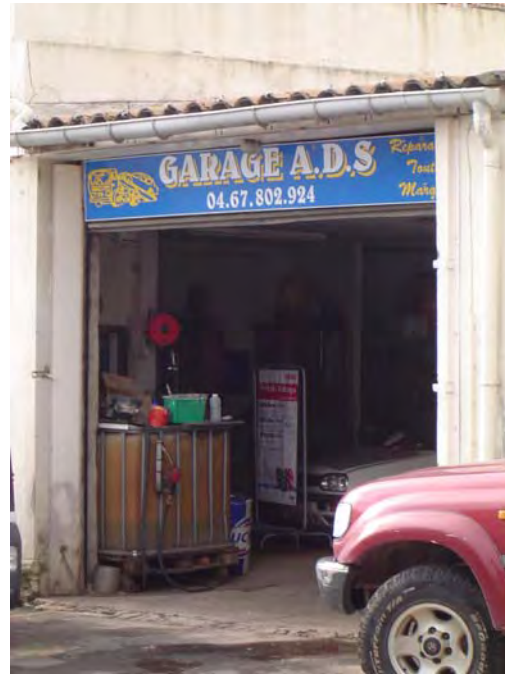
Aucun dispositif d'arrimage ne semble avoir été prévu pour immobiliser la citerne en cas d'inondation (garage avenue de Sérignan)
