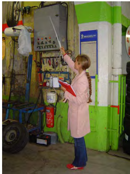
La hauteur de la crue de 1996 dans ce local montre la difficulté de protéger les installations électriques et autres équipements sensibles
