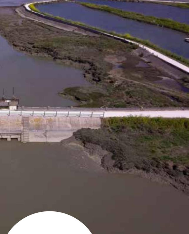
L'ouvrage hydraulique des Eveillards (Loix, Ile de Ré) est un ouvrage pleinement intégré à la logique « Gemapienne » : gestion hydraulique de l'alimentation des marais salés et protection contre les submersions.
